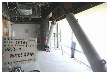
施工状況（内装を一部撤去後ブレース設置）
