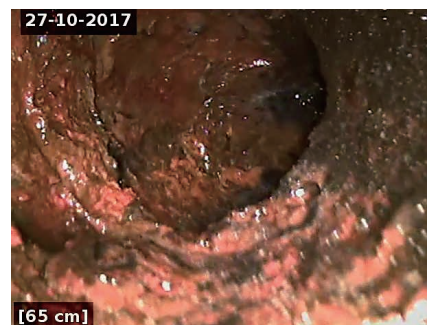
ファイバースコープで配管内部を調査
