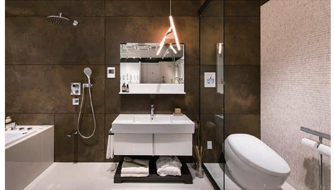
バス・トイレの壁に大型陶板（TOTO ハイドロニロッド）を用いた例
