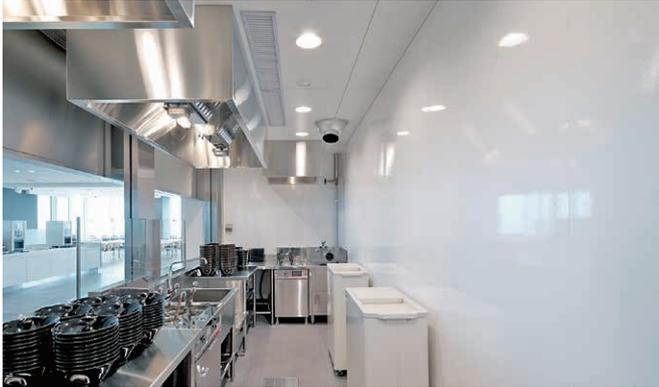
厨房の壁に大型陶板（TOTO ハイドロセラ）を用いた例
